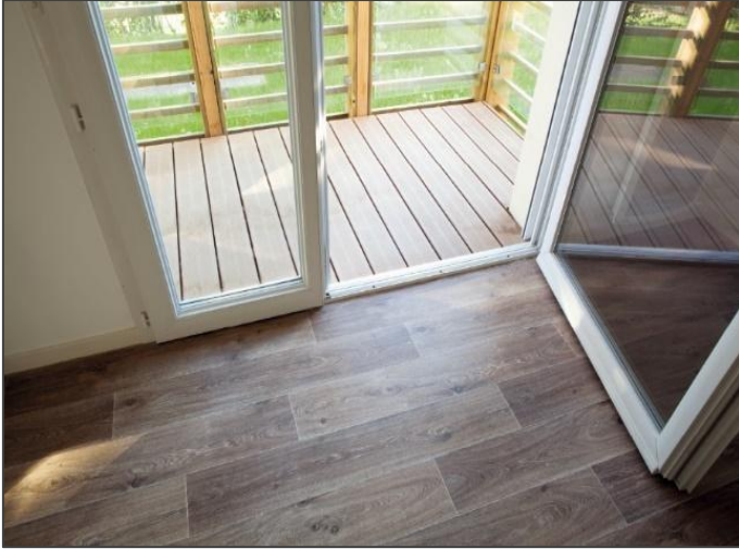
ACCÈS ADAPTÉS SANS SEUIL
