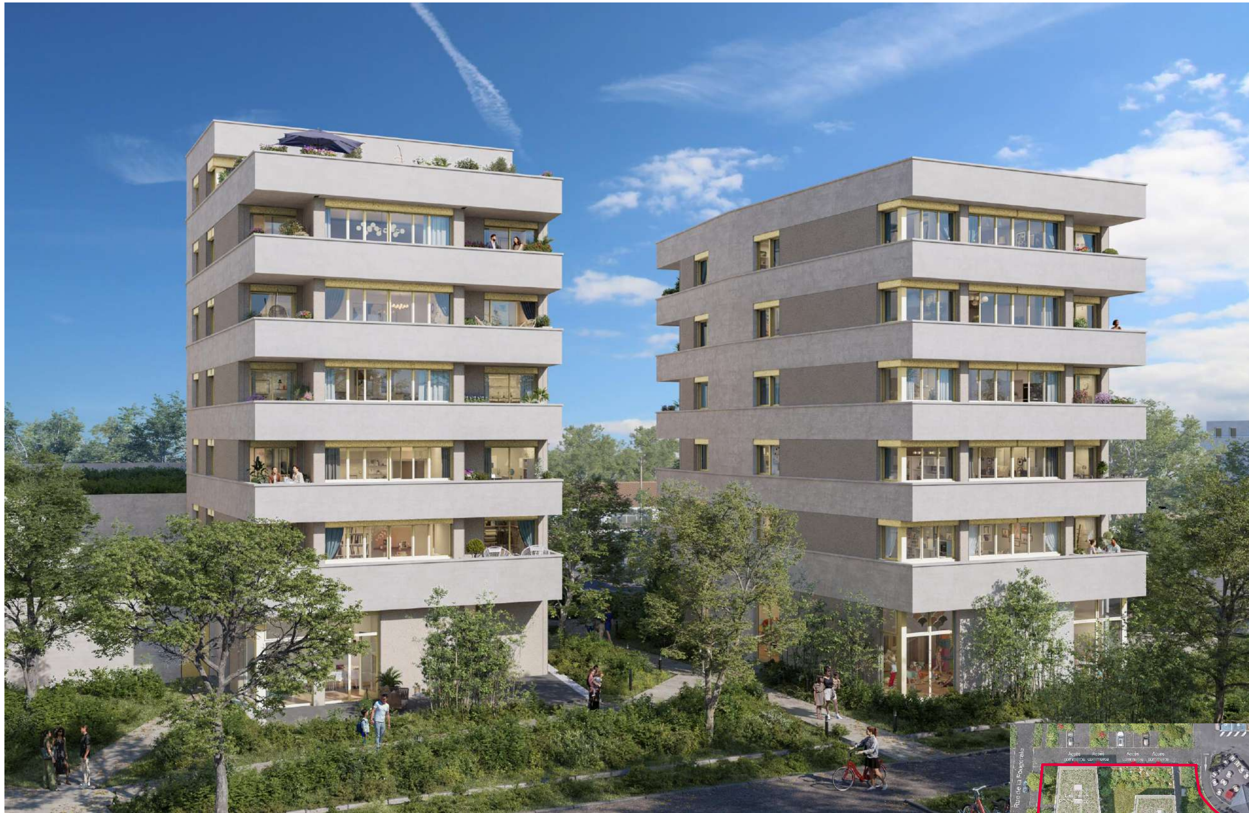
Vue sud – bâtiments B et C
