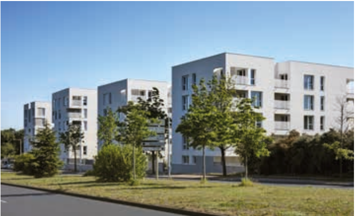
City Garden - Vénissieux Architecte : Cabinet Insolites Architectures
