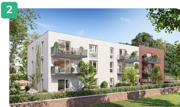
Vue depuis l'arrière
