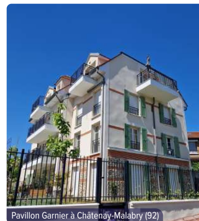
Pavillon Garnier à Châtenay-Malabry (92)
