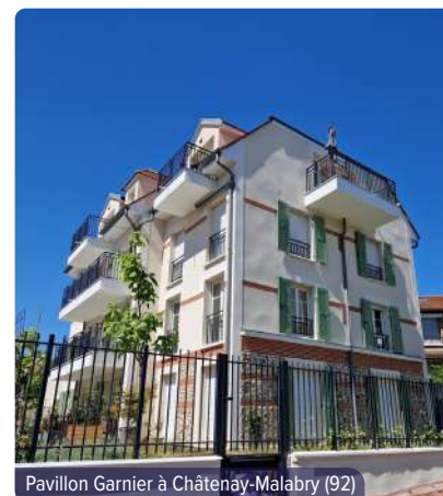
Pavillon Garnier à Châtenay-Malabry (92)
