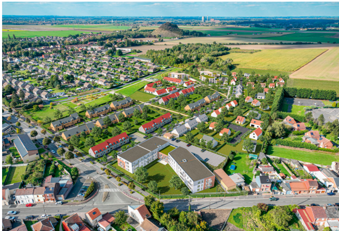
Vue aérienne du Domaine d'Ombrage
