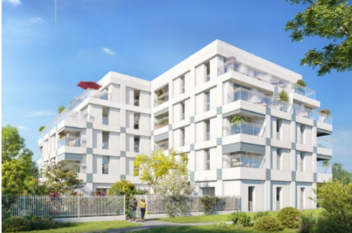
3 Vue cœur d'îlot du bâtiment B
