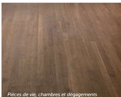
Pièces de vie, chambres et dégagements
